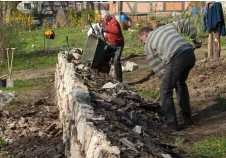
Bau der Natursteinmauer – Hinterfüterung mit Mergel
